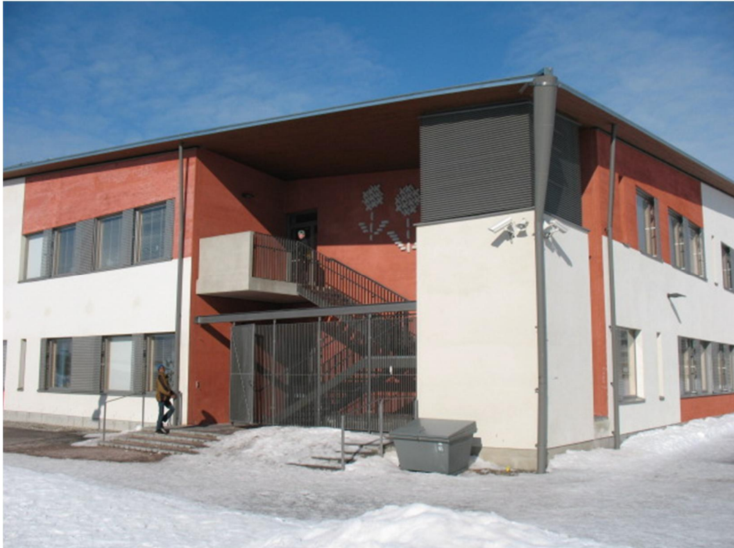
Kuva 1. Raitisilmatorni koulun kulmassa.
