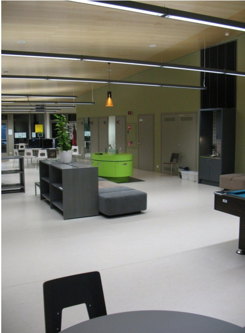
Kuva 11. Kotiaulan poistoilmasäleikkö poistoilmatorniin.
